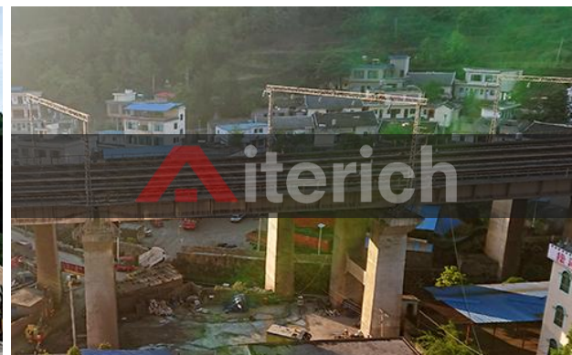
贵州盘州四线桥健康监测项目
