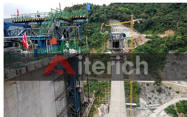
云南把边江在建大桥监测项目
