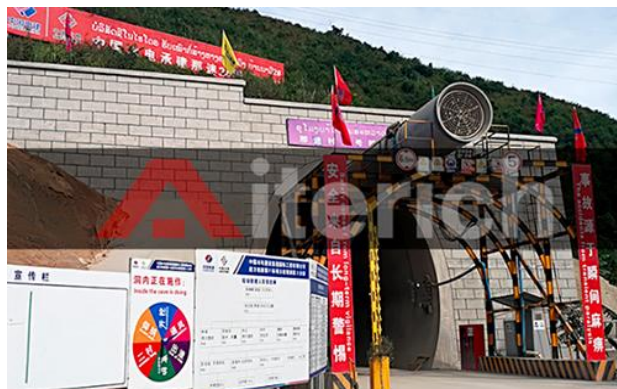
老挝卡西隧道风险实时监测预警项目
