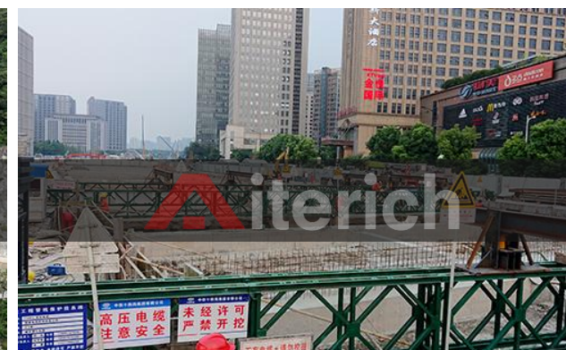
杭州望江隧道高压管廊监测顶升项目
