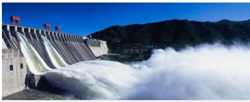
大坝安全监测
