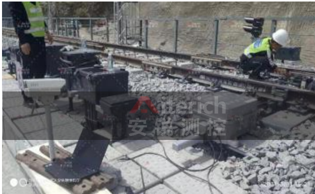
拉萨道岔二维码位移监测项目
