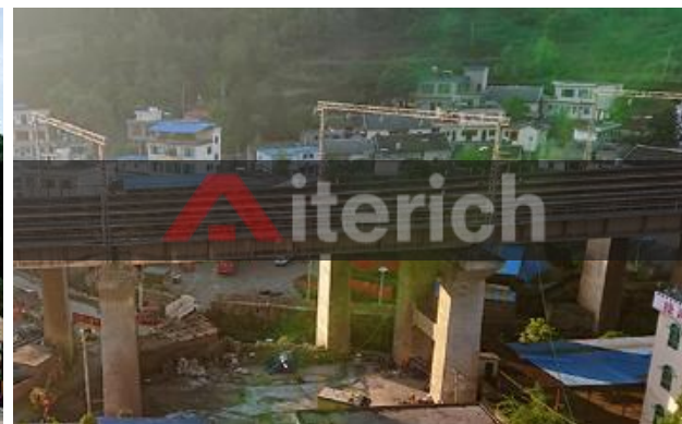
贵州盘州四线桥健康监测项目
