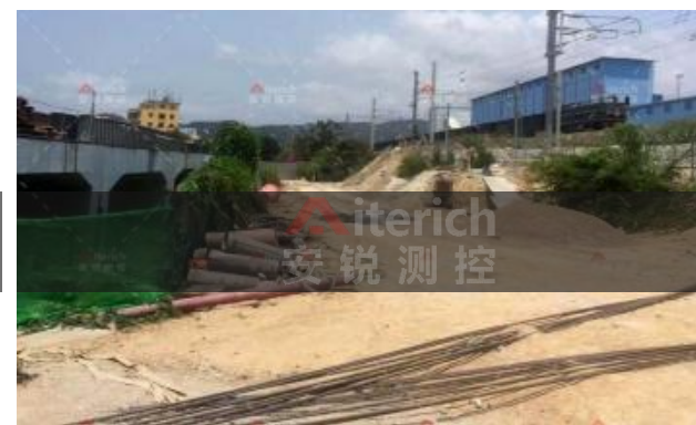
南宁铁路周边施工监测项目
