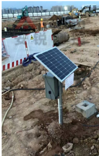
福建基坑土体监测
