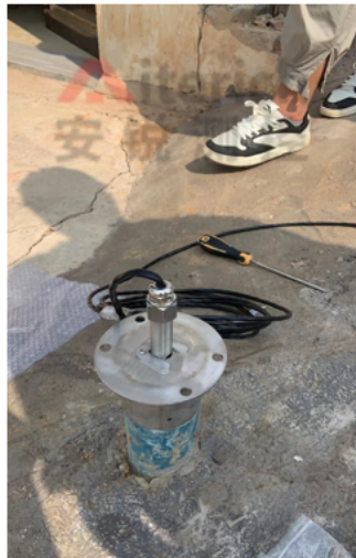
河南建筑基坑监测
