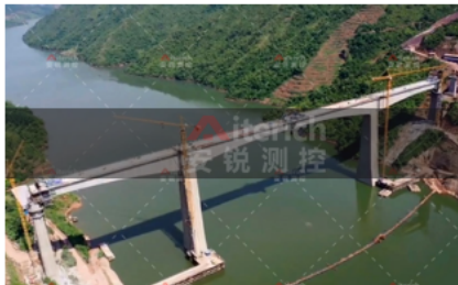
阿墨江在建双线特大桥监测项目
