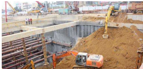
地铁地基安全监测
