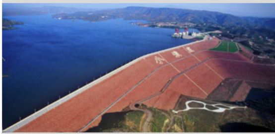
大坝安全监测
