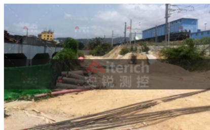
南宁铁路周边施工监测项目
