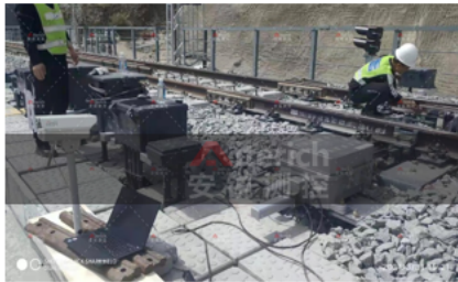
拉萨道岔二维码位移监测项目
