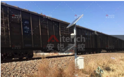
毕节铁路周边软基监测项目
