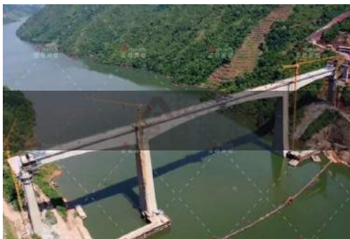
阿墨江在建双线特大桥监测项目
