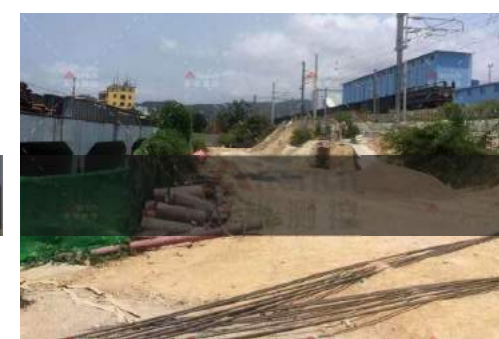
南宁铁路周边施工监测项目
