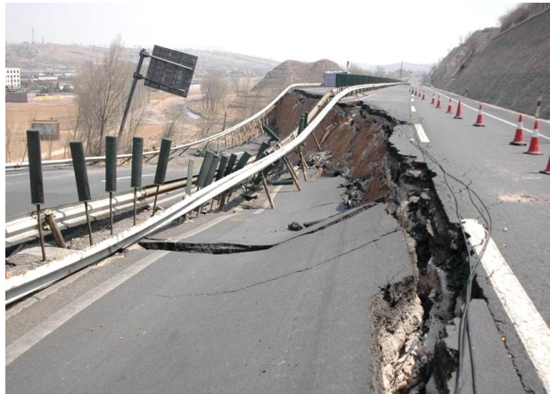
路面路基沉降监测
