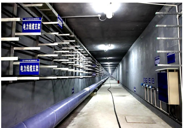
管廊沉降监测
