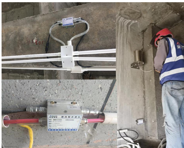
青海玉树某 市政大桥 沉降监测
