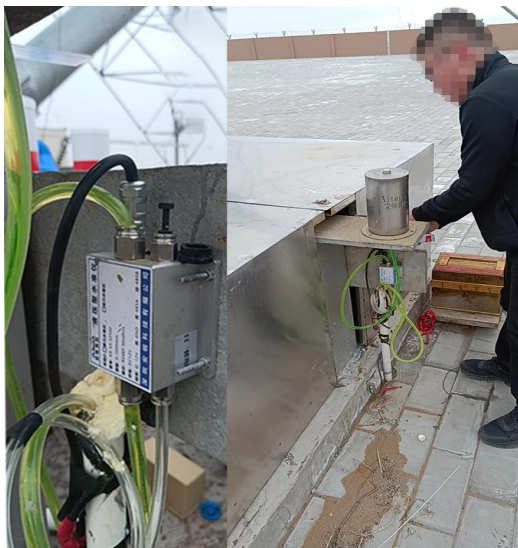
太原某 电力铁塔 监测
