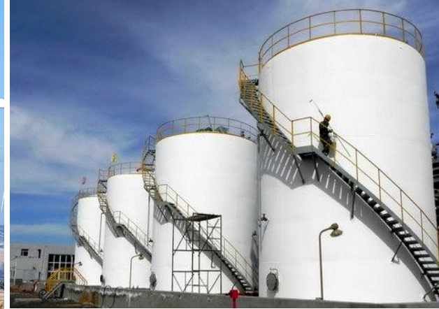
大型储物罐沉降监测
