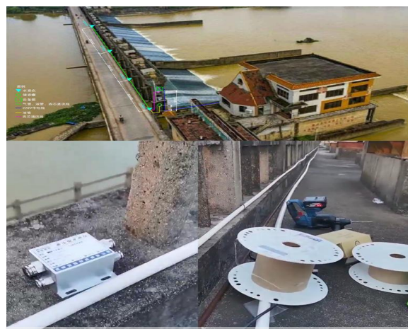
广东河源某 闸站 沉降监测
