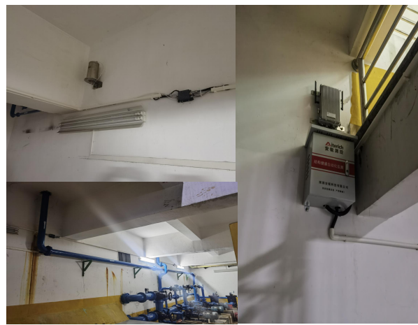
惠州某 闸站 沉降监测
