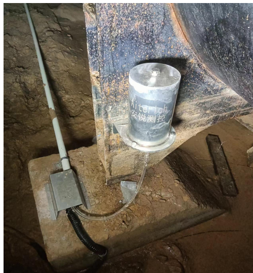
广东韶关 管廊 沉降监测
