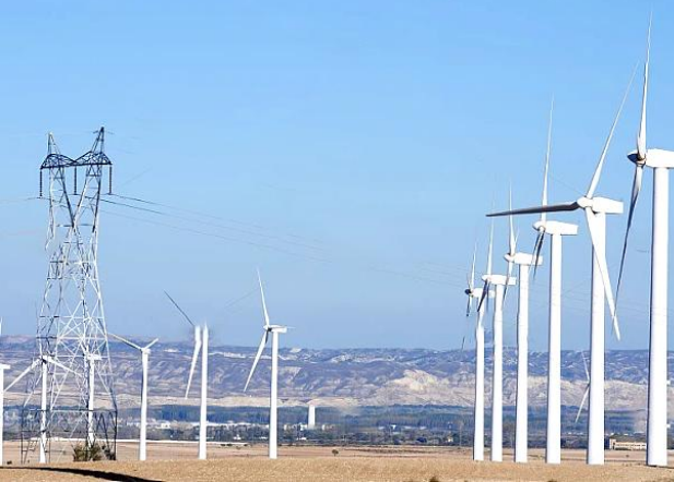
风机/铁塔基座沉降监测
