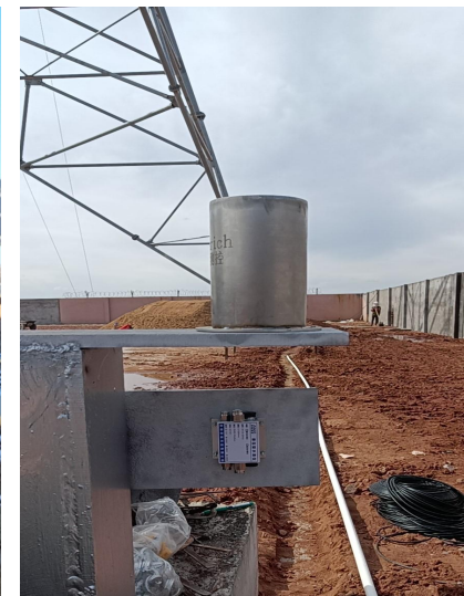
广州某电力 铁塔 监测
