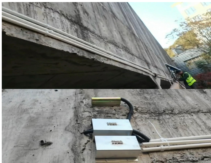
贵州 公路桥梁 沉降监测
