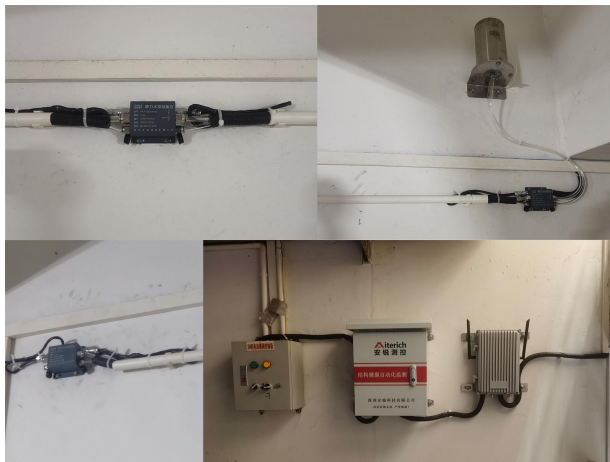
长沙某园区 楼房 沉降监测
