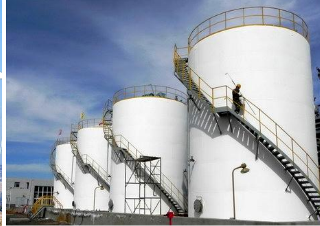
大型储物罐沉降监测
