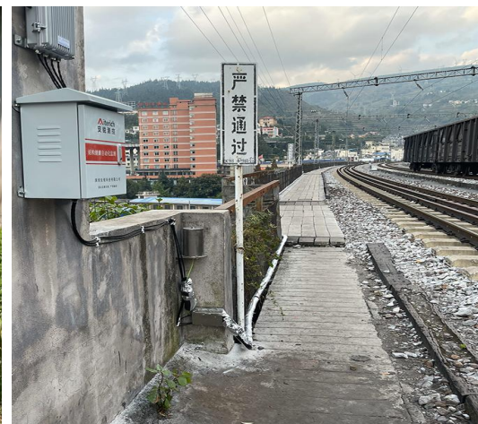
松河 铁路 沉降监测
