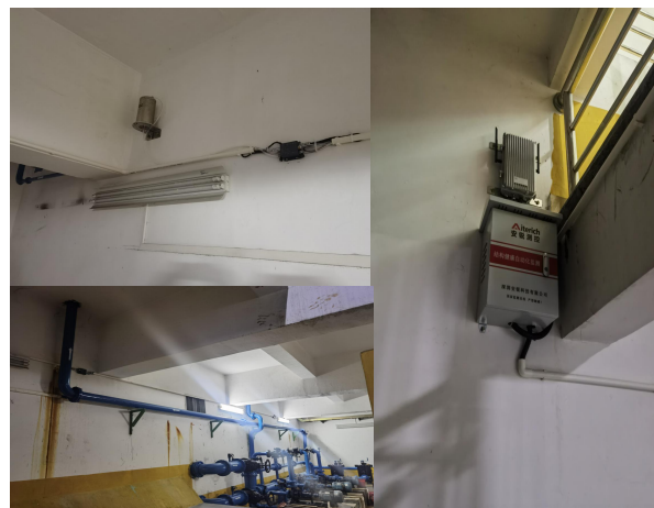
惠州某 闸站 沉降监测
