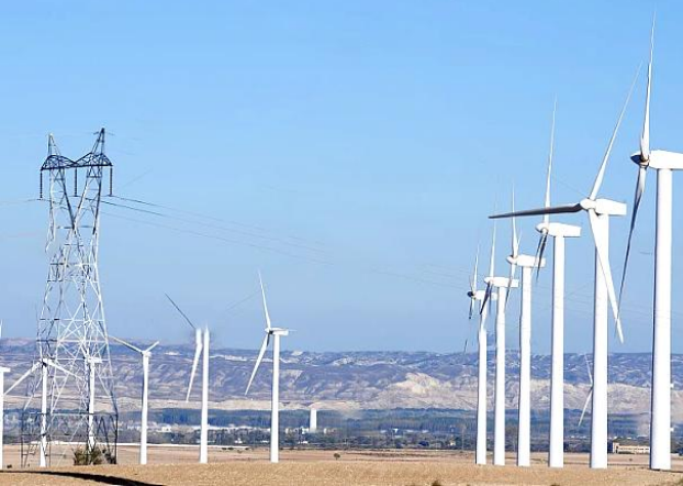
风机/铁塔基座沉降监测
