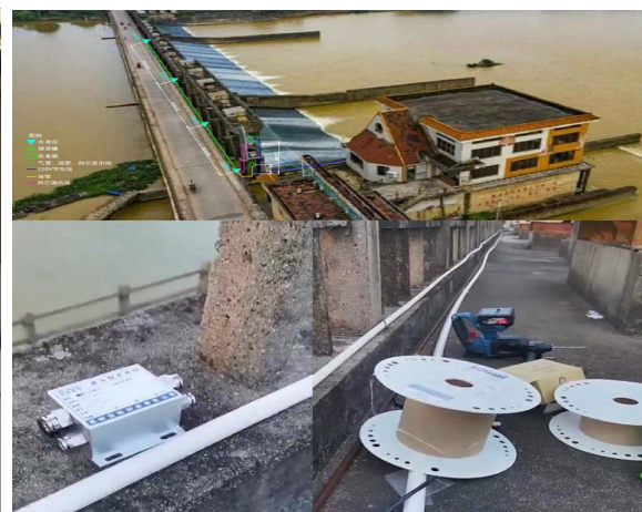
广东河源某 闸站 沉降监测
