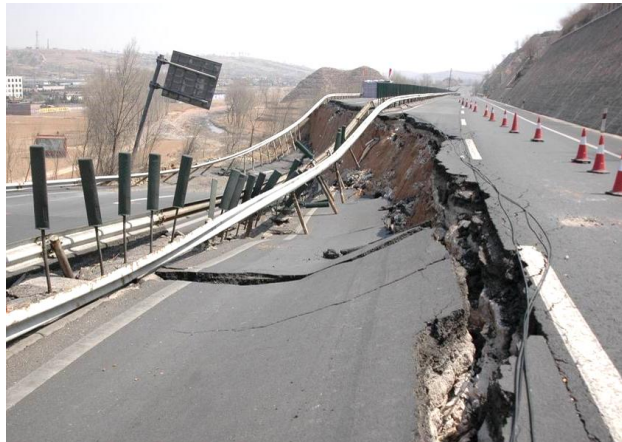
路面路基沉降监测
