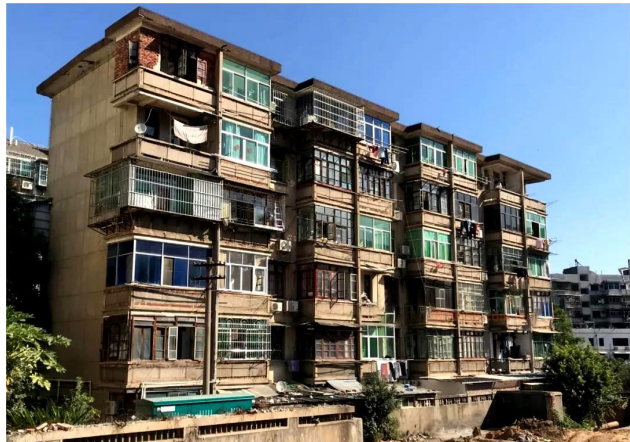
房屋/危房沉降监测
