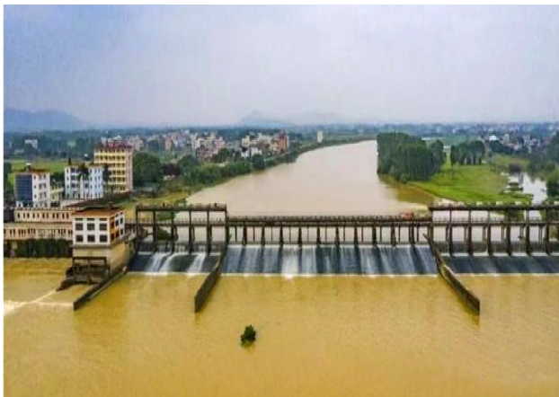
大坝/闸站/变电站沉降监测
