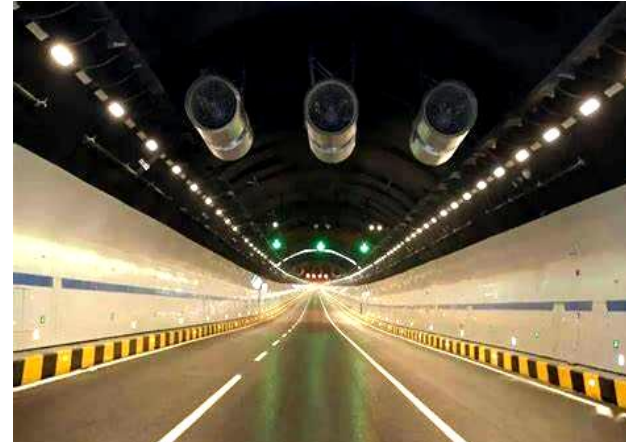
隧道沉降监测
