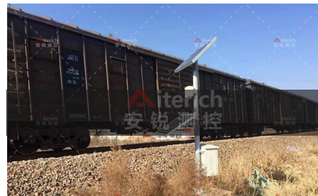
毕节铁路周边软基监测项目
