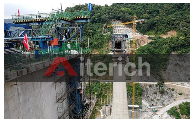
云南把边江在建大桥监测项目
