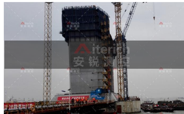
上海沪通大桥液压爬模监测项目
